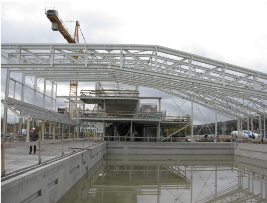
Sportcomplex Amerena in aanbouw (foto: ZPC Amersfoort)
