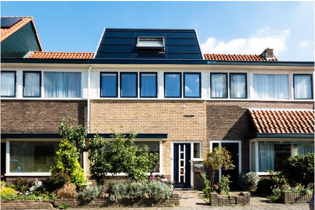
Jaren 30 woning Hunzestraat, naar Nul-op-de-Meter gerenoveerd
